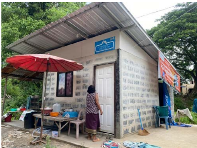
ภาพที่ 6.4. 4 บ้านของผู้สูงอายุที่ได้รับ การสร้างให้ใหม่หลังจากโดนน้ำท่วม (ยังมีร่องรอยน้ำท่วมอยู่ผนังบ้าน) ที่มา: ถ่ายโดยทีมวิจัยภาคสนามจังหวัด อุบลราชธานี
