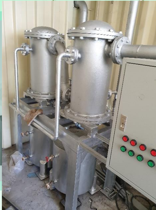
รูปที่ 5 เครื่องแลกเปลี่ยนความร้อนด้วยน้ำ (Condenser)
